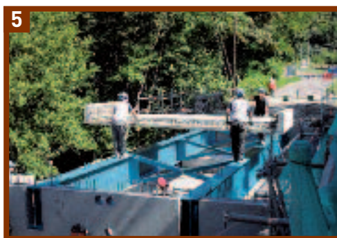
Pose des tabliers en béton
