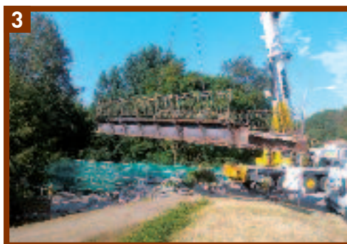
Dépose de l'ancienne structure
