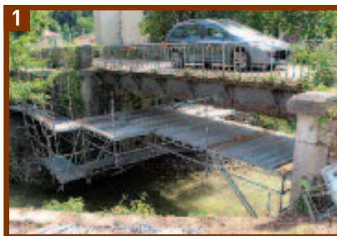
Le Pont de la Patinière AVANT les travaux
