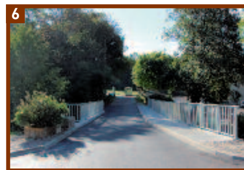
Le Pont de la Patinière APRÈS les travaux
