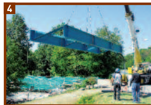
Pose de la nouvelle structure métallique
